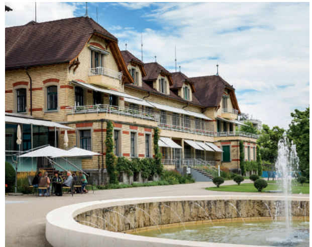
Ästhetisch integrierte Absturzvorrichtungen ermöglichen die Erweiterung von bewohnergerechten Lebensräumen
