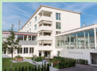
ROSENGARTEN, Gossau ZH Pflege- und Betreuungszentrum Tel. +41 44 552 68 00 www.rosengarten-gossau-zh.ch
